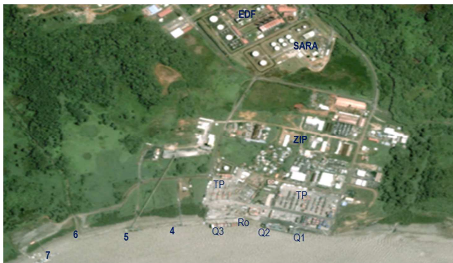
Vue aérienne du port de Dégrad-des-Cannes - implantation des postes à quai (crédit photo GPM)
