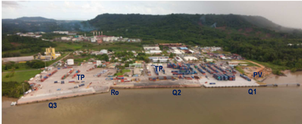
Vue aérienne du port de Dégrad-des-Cannes - implantation des postes à quai (crédit photo GPM)
