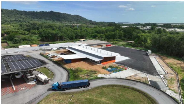
Figure 40 : Vue aérienne à date du chantier du Poste Frontalier Communautaire
