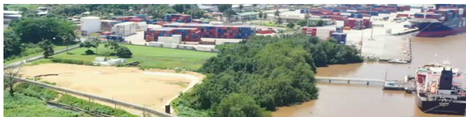
Figure 17 : Terrain traversée par les pipelines du terminal pétrolier
