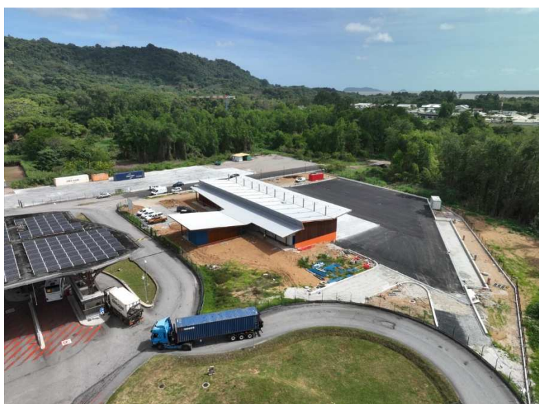
Figure 19 : Aménagements en cours sur le Secteur 1
