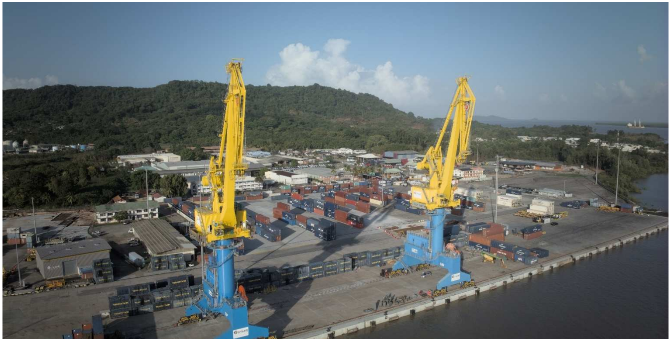
Figure 6 : Quais 1 et 2 équipés de grues sur rails
