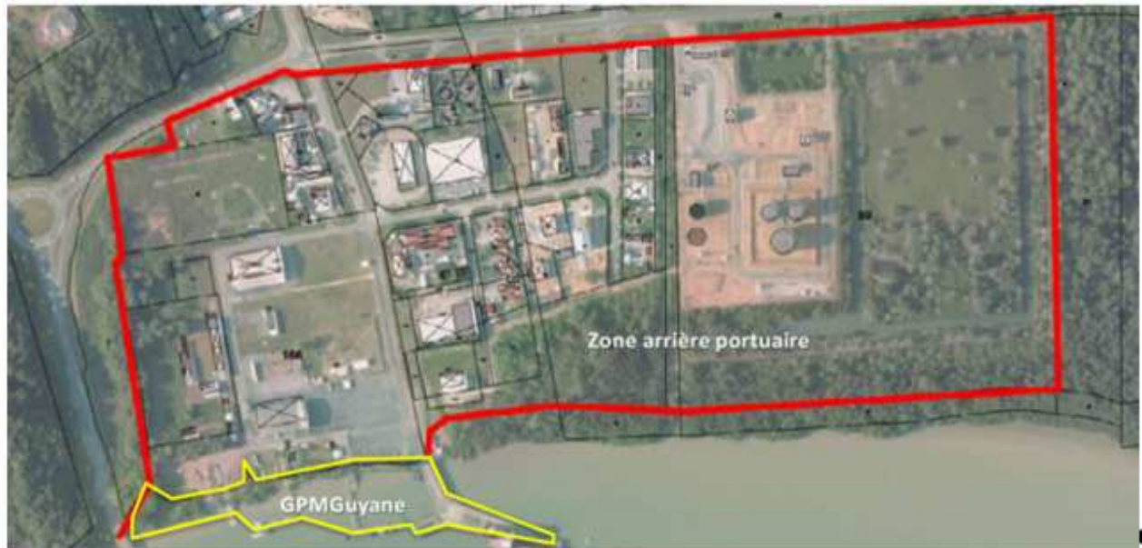
Figure 104 : Aire d'étude immédiate : circonscription portuaire du GPM-Guyane sur Kourou Pariacabo (rouge) et périmètre administratif (jaune)
