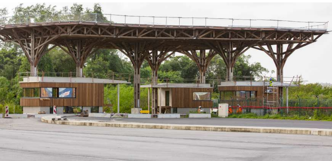
Nouveau Poste de contrôle avec ses 340 panneaux photovoltaïques. © Ronan Liétar
