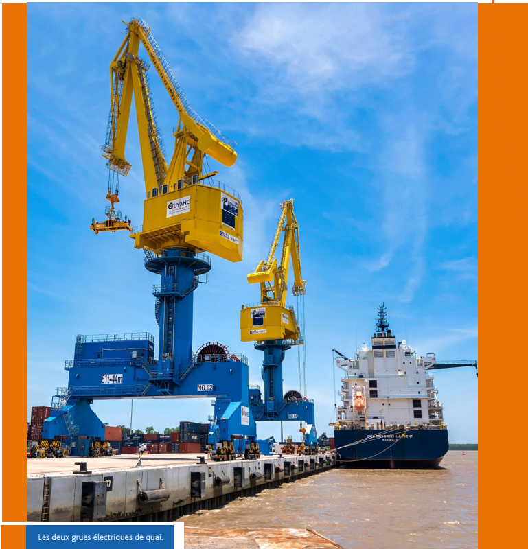
Les deux grues électriques de quai.
